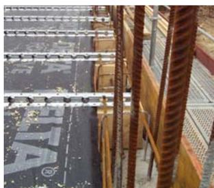
Applicazione in cantiere del sistema di unione Traliccio LPR® - cordolo.
