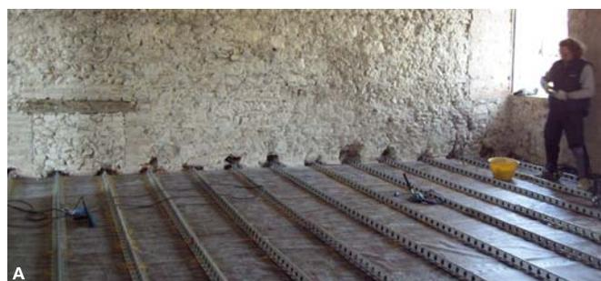
Attenzione però. Il consolidamento con solette di calcestruzzo collaboranti con le travi di legno realizza una partizione orizzontale rigida. Ancor più dunque è necessaria la cerchiatura dell'edificio per distribuire le sollecitazioni orizzontali del sisma! (foto B)
